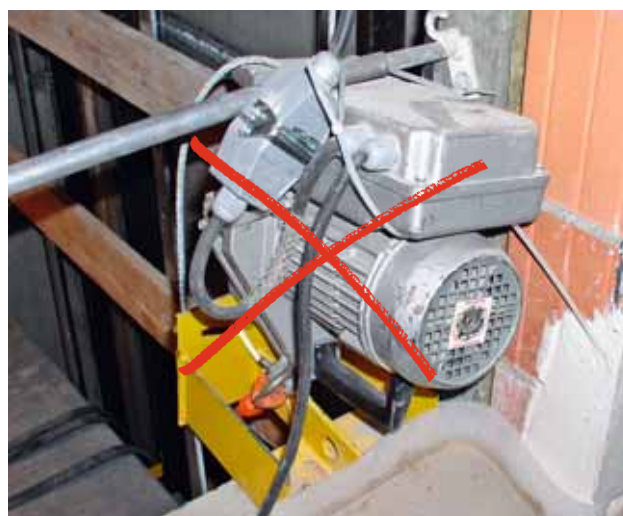
22 Utilizzare solo apparecchi di sollevamento concepiti per il trasporto di persone.
